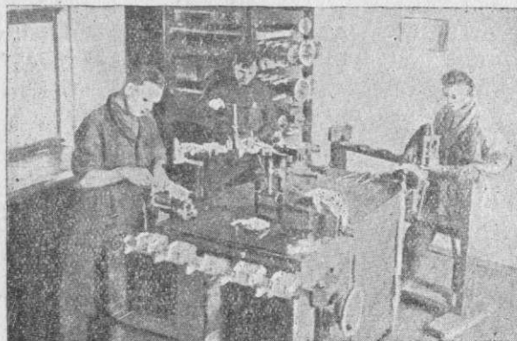
Рис. 125. Шабровка крышек коромысел.
