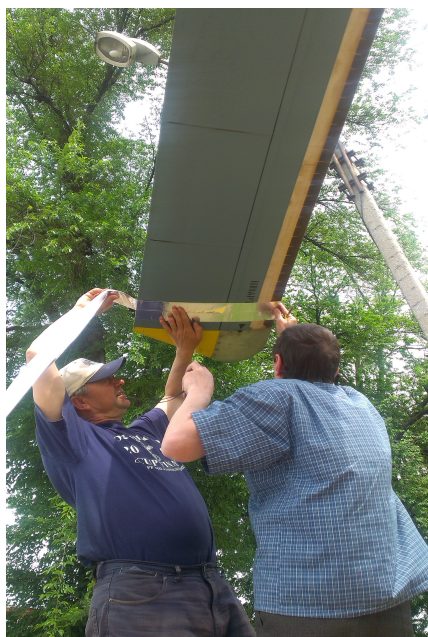
Рис. 2. Установка светоотражающей ленты на лопасть НВ
