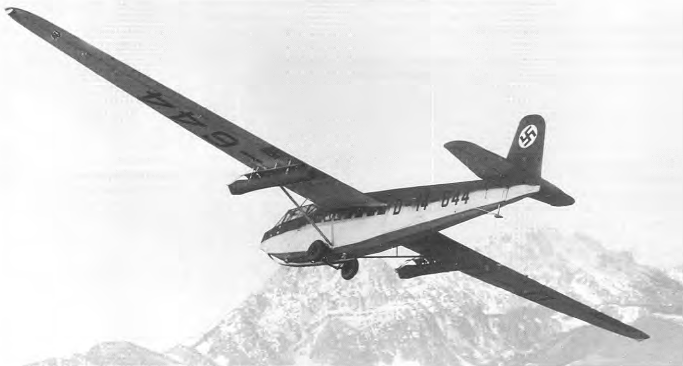
Рис. 8.19. Планер DFS 230 (D-14-644), предназначенный для проведения летных испытаний двух пульсирующих воздушно-реактивных двигателей Argus 300 мм. В качестве «летающей лаборатории» этот десантный планер имел достаточный внутренний объем для размещения испытательного оборудования и различных установок топливных систем
