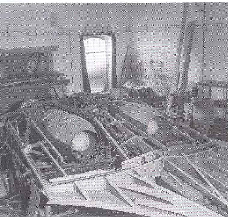
Рис. 2.67. Строящийся опытный образец истребителя Гота Go 229, выполненный по конструкции «летающее крыло», с двумя двигателями Юнкерс 109-004 С. Этот завод вблизи Фридрихсроде был захвачен войсками VIII корпуса 3-й армии США 14 апреля 1945 года. (Снято фотографом сухопутных сил США)
