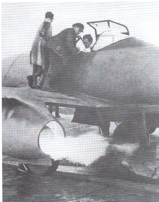
Рис. 2.40. Предсерийный самолет Мессершмитт Me 262 А-0 во время запуска левого турбореактивного двигателя Юнкерс 109-004 В-1 летчиком-испытателем. С помощью этого варианта двигателя пытались устранить плохое распределение скоростей выхлопных газов
