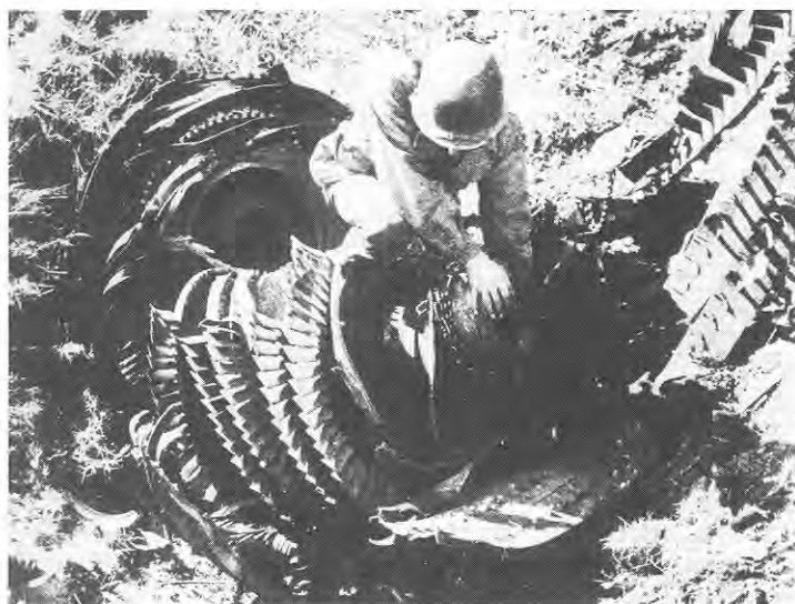
Рис. 2.106. Компрессор, который был завершен к концу войны в Стассфурте для турбореактивного двигателя BMW 109-018, но затем был уничтожен, чтобы не попасть в руки противника
