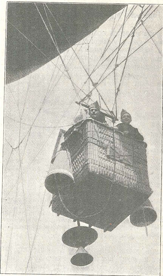
Рис. 6. Способ подвески парашютов, упакованных в футлярах, у корзины змеякового аэростата.
