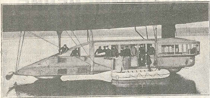
Рис. 3. Гондола морского дирижабля LZ — 72. Около гондолы видна складная парусиновая шлюпка, имеющаяся на дирижабле.
