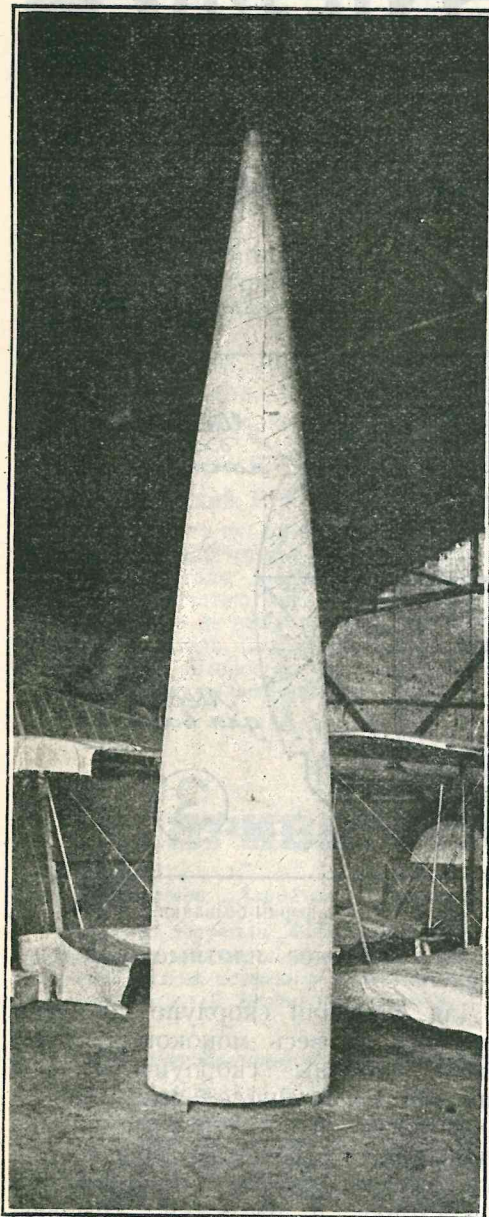
Рис. 5. Скорлупа, снятая с формы.
