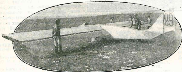
Рис 4. Оригинальный 2-местный планер „Владимирский Пионер“ Кольчугинского Авиакима, сделанный из кольчугалюминия.
