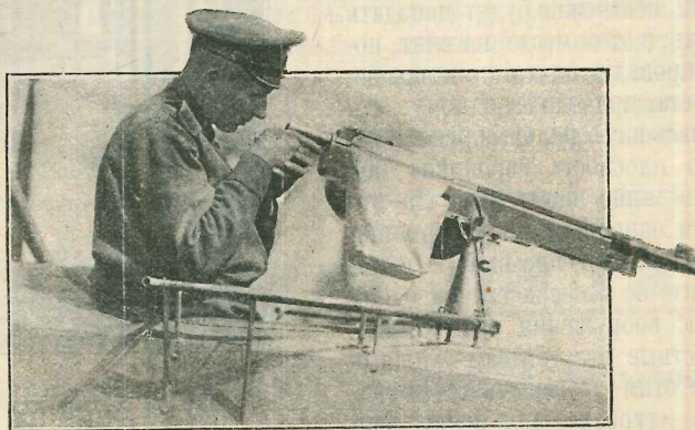
Рис. 5. Турель завода Лебедева типа 1916 г. На турели пулемет Кольта.
